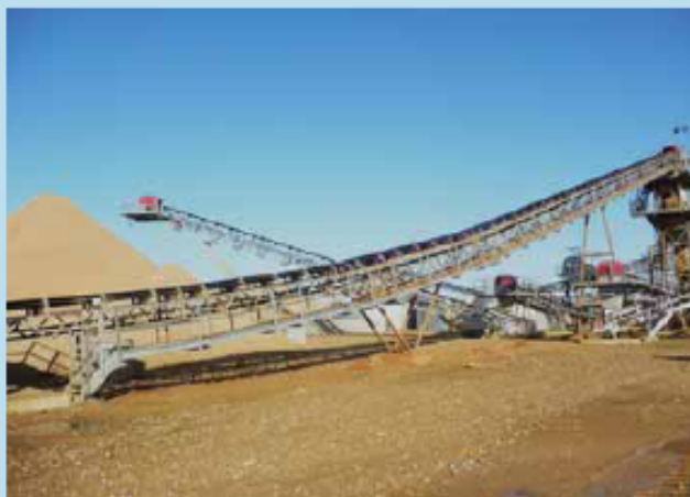
Le site Minier SA de Saint-Jean-Froidmentel présente des équipements particulièrement modernes pour la production, le traitement des matériaux et le recyclage de l'eau.
