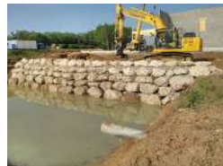
Réalisation de bassin en enrochement sur le chantier « Dargaise » à Vendôme
