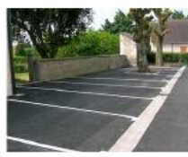
Parking, voirie, plateforme
