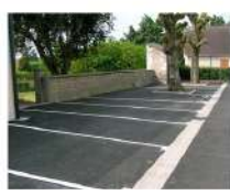
Parking, voirie, plateforme
