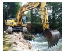
Aménagement cours d'eau et étangs
